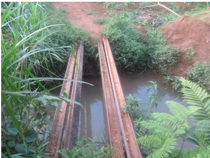
N° 3 : Passerelle à base de barres de chemin de fer, posée par les populations ; « dangereuse pour les enfants »
