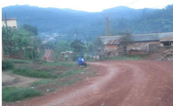
N° 7 : Route non-bitumée : Ndokovi-Bacheu ; etc
